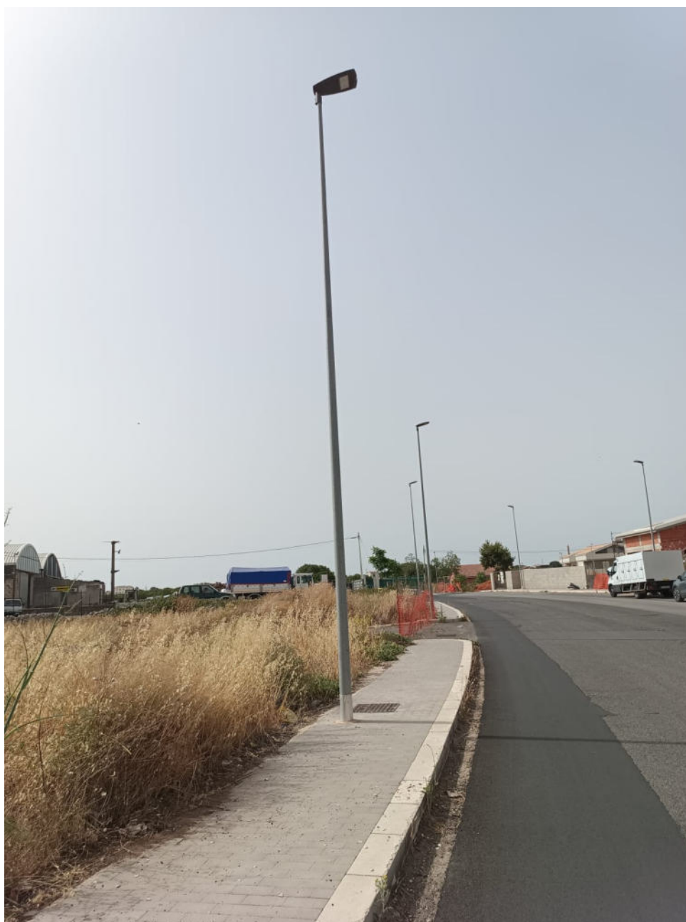
Vista attuale dell'allargamento strada statale n.106, in corrispondenza dell'ingresso della strada di lottizzazione, completo di pavimentazione , di marciapiedi e dei pali della pubblica illuminazione
