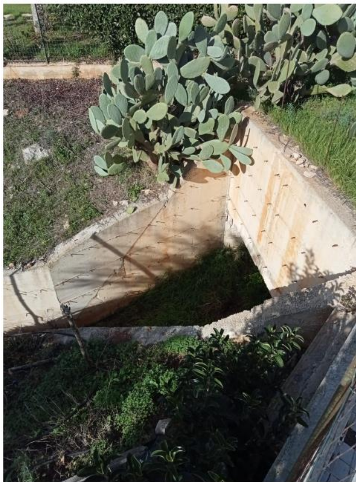
Fig.33 - Imbocco del canale di via Ecrivà nel suo breve tratto sottotraccia in culvert.
