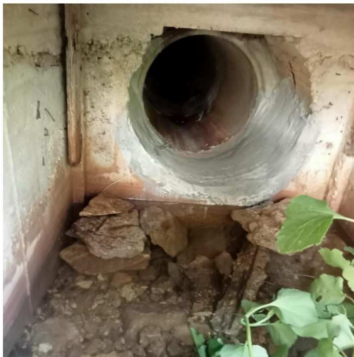
Fig.27- ingresso del culvert di via Spata, d= 500 mm.
