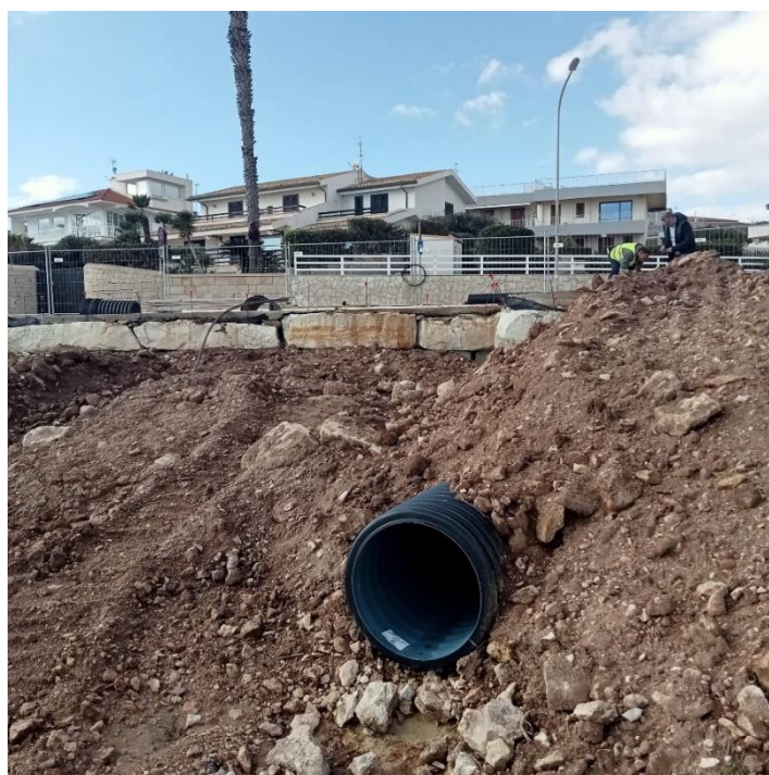
Fig.27- ingresso del culvert di via Spata, d= 500 mm.
