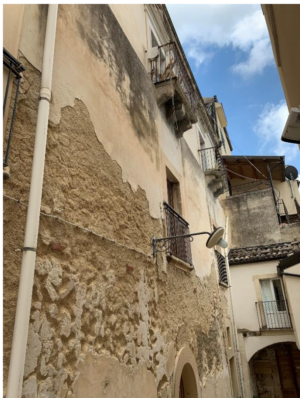
Figura 4: Prospetto su Via Balate
