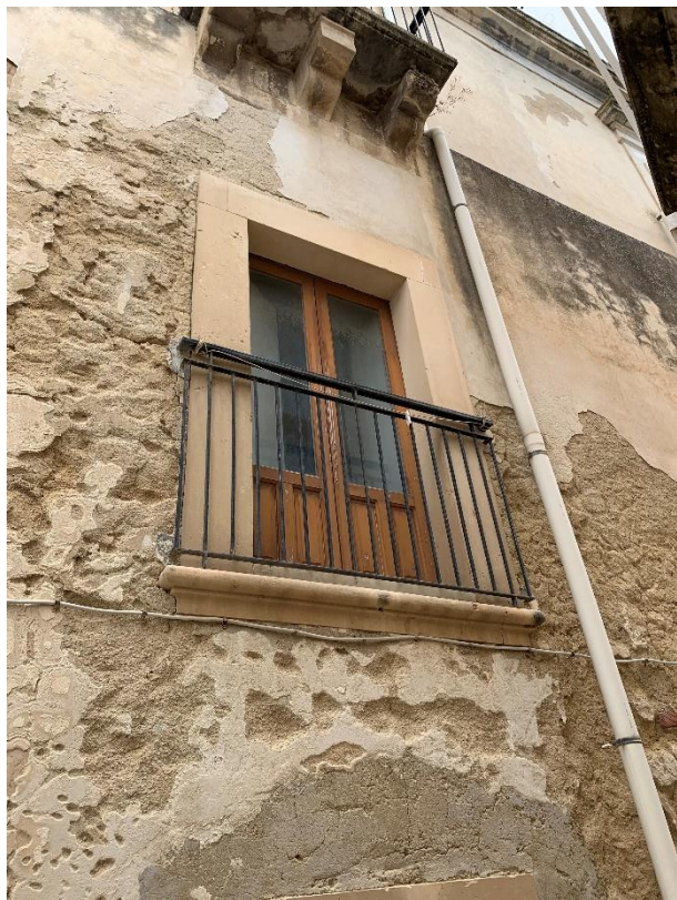
Figura 3: Prospetto su Via Balate
