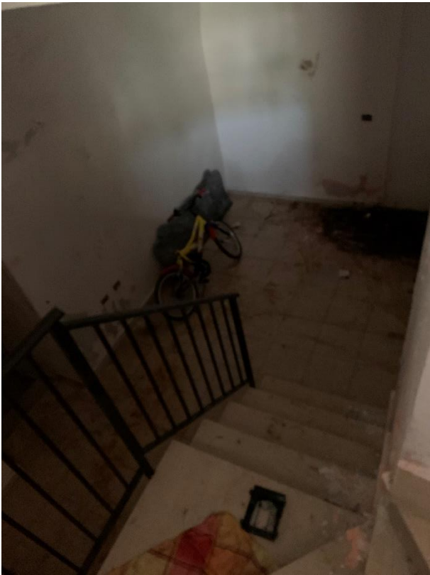
Figura 8: Vista interna da scala
