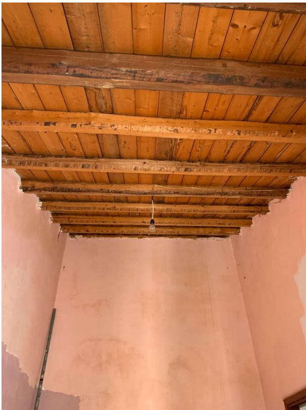
Figura 5: Vista tetto da camera doppia
