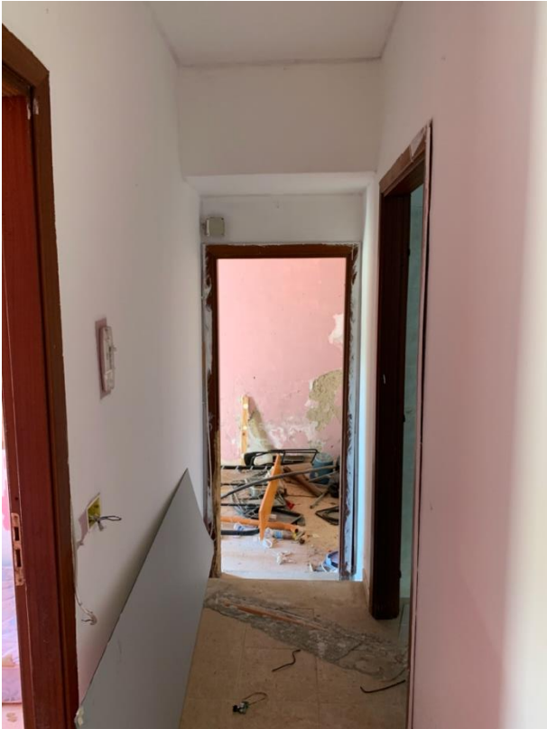
Figura 4: Corridoio piano terra
