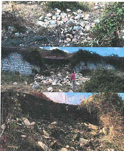
**4. Controripa - Rifacimento di mq. 50.00 di muro a secco**
