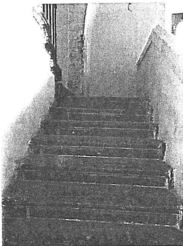
Scala alla "catalana". Rampa al livello ammezzato
