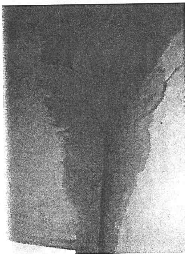
Particolare di infiltrazioni da copertura su parete a terzo livello
