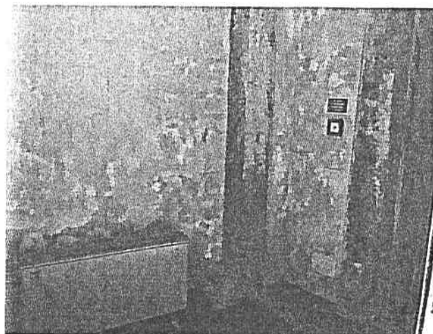
Vano d'ingresso a primo livello. Particolare umidità di risalita
