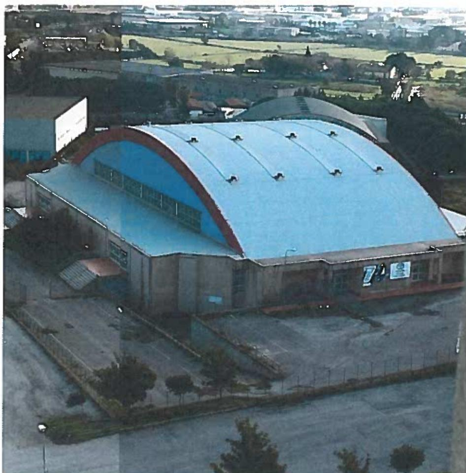
A causa della corrosione della lamiera preverniciata si verificano frequenti infiltrazioni di acqua piovana che oltre a danneggiare il tavolato di copertura, causano problemi alla pavimentazione, in parquet di legno, del terreno di gioco.
