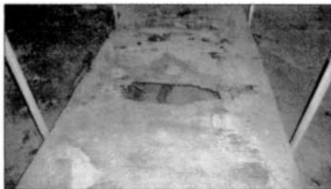
All'interno della Latomia del Genio Civile il tavolato risulta in alcune zone fatiscente
