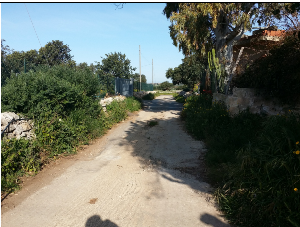
STRADA IN C.L.S. – INGRESSO POTABILIZZATORE
