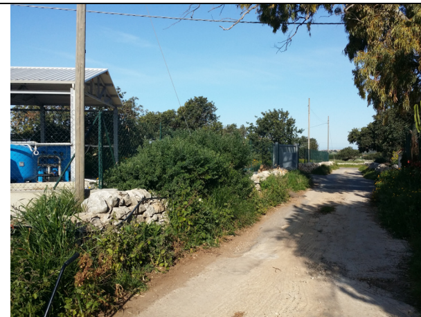
STRADA IN C.L.S. – INGRESSO POTABILIZZATORE
