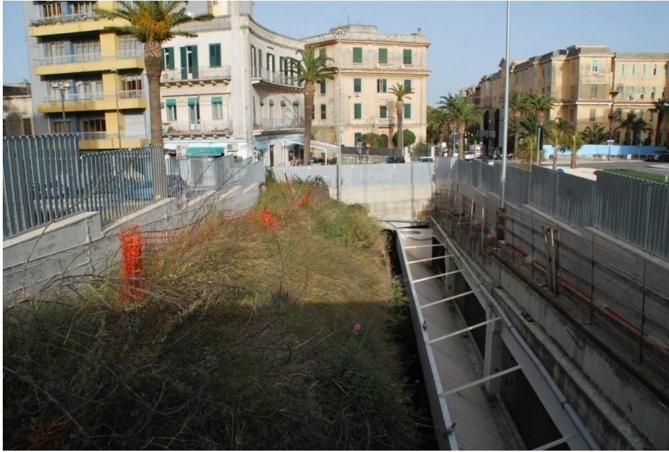
Camino di aerazione nord
