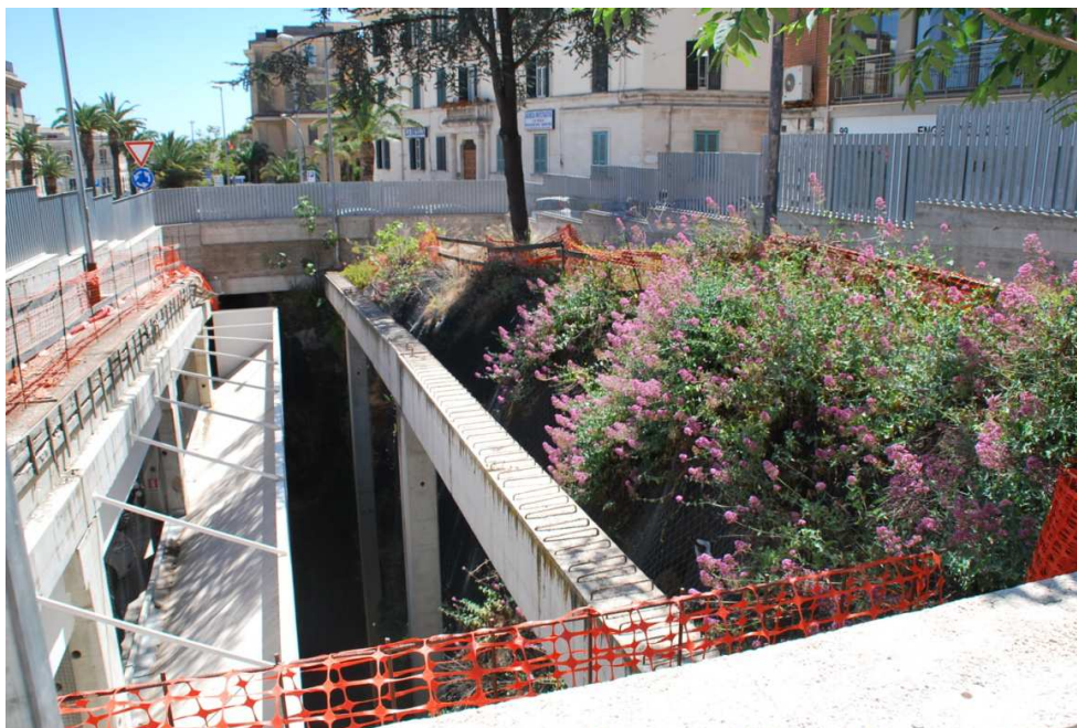
Camino di aerazione su
