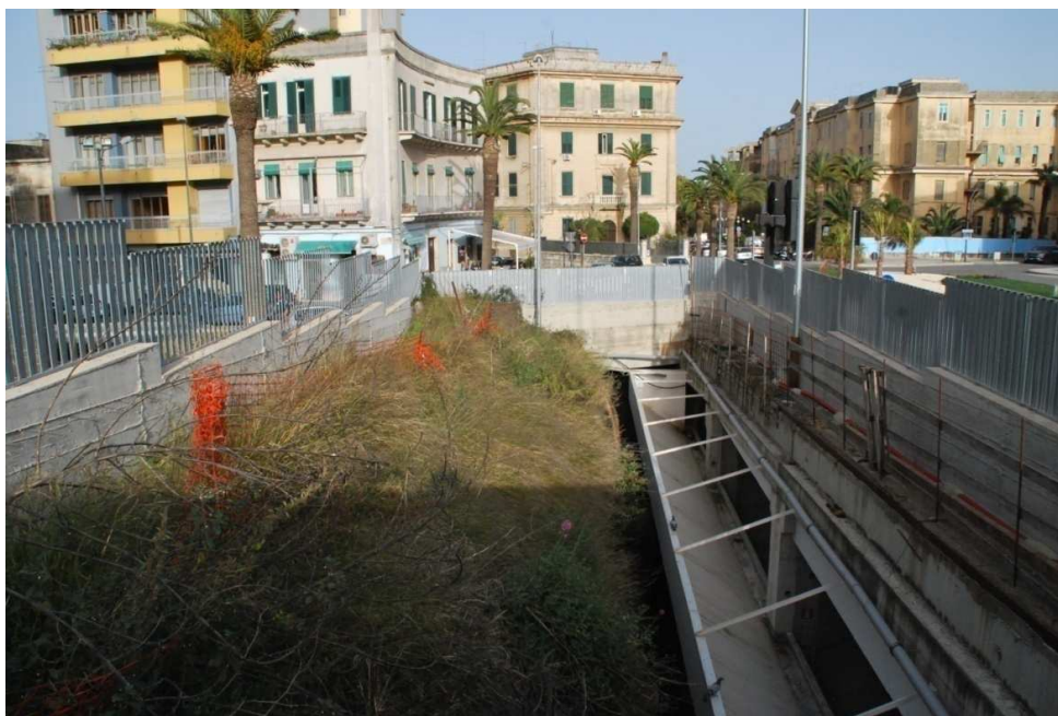
Camino di aerazione nord
