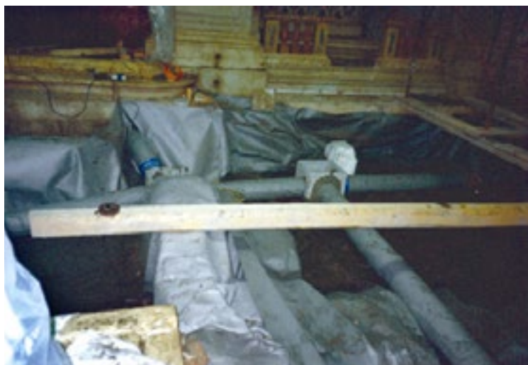
Fig.7 - Chiesa di S.Antonin: particolare del sistema di drenaggio.
