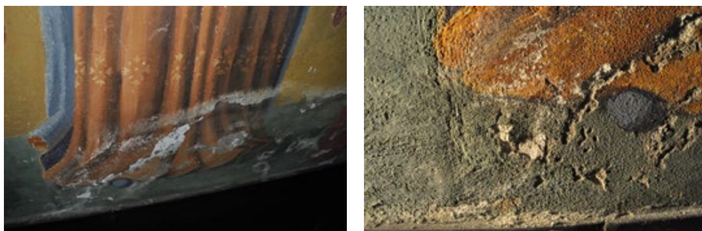
Fig. 14 – Esempio del grave stato di degrado delle superfici murarie decorate.
