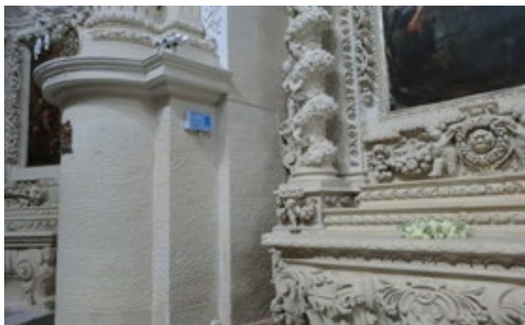
Fig.7 - Installazione dell'apparecchio a neutralizzazione di carica Domodry.
