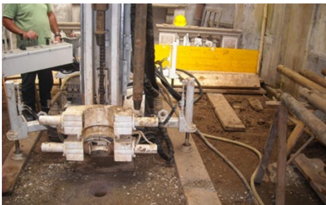
Foto 7 – Sondaggi con videoispezioni.
