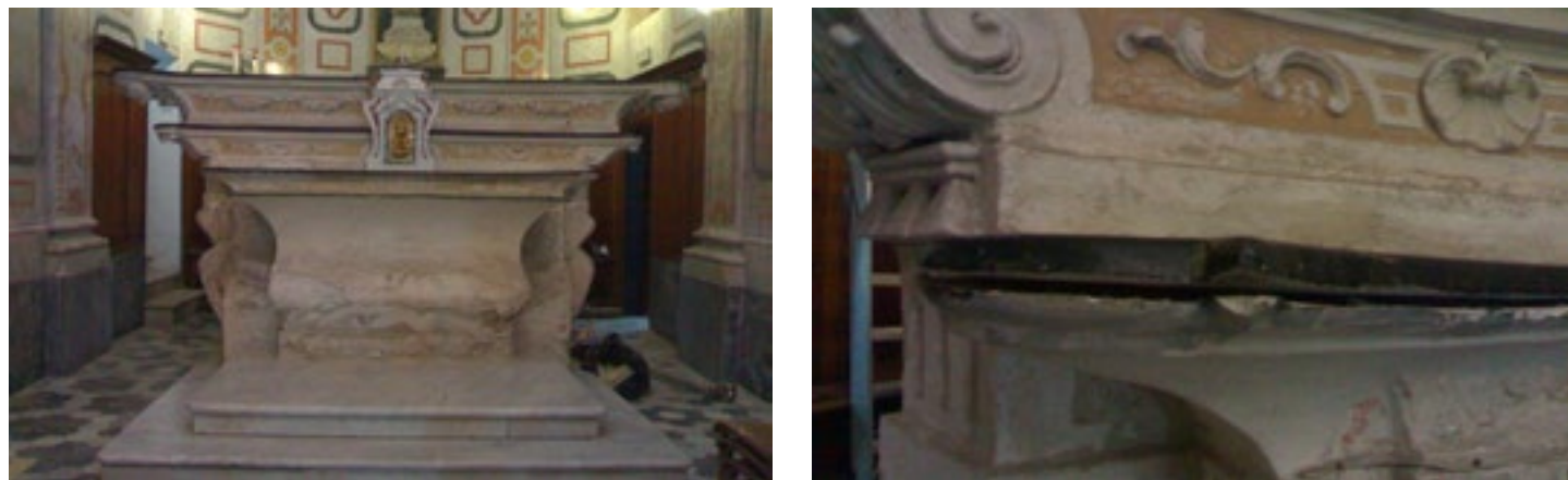
Fig. 20 - L'altare in stucco, completamente sfarinato e a rischio di crollo.
