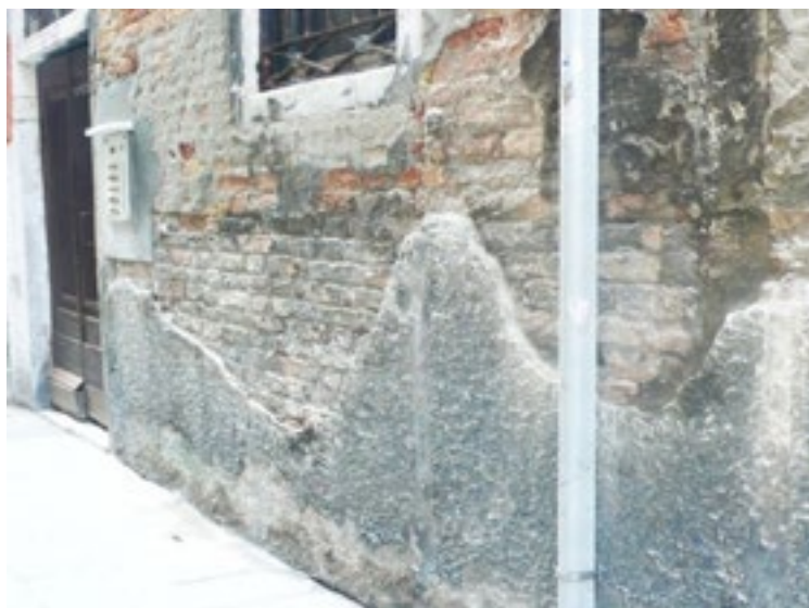
Fig. 5 - Esempio di utilizzo di intonaci che dopo poco tempo subiscono un forte degrado.
