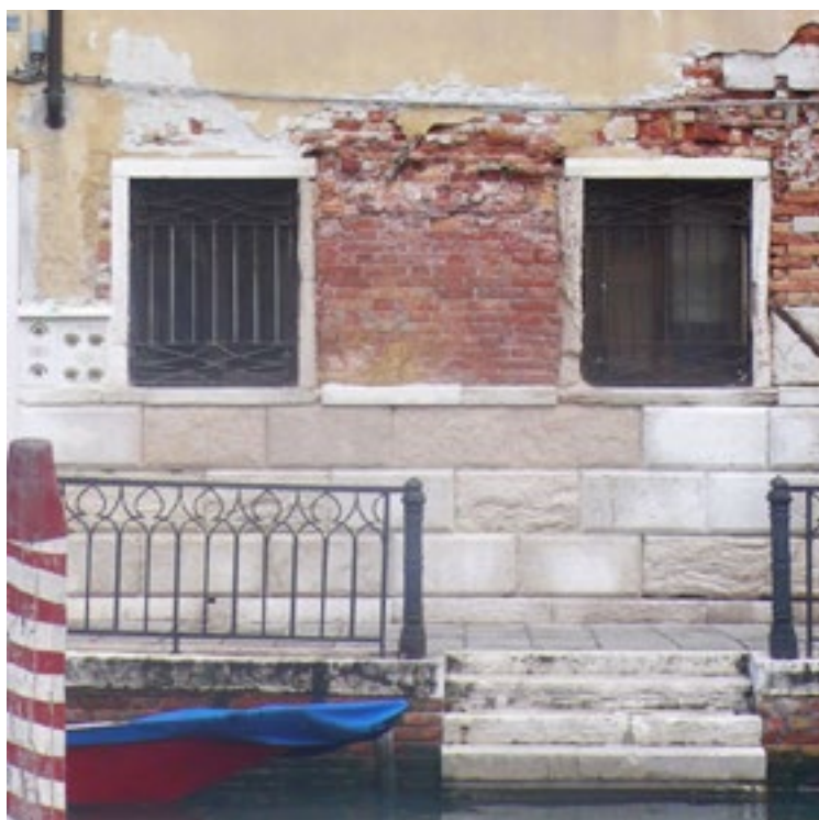
Fig. 4 - Un tentativo di tamponamento della parte bassa del muro con il conseguente innalzamento del fronte di umidità ben oltre il tamponamento stesso.
