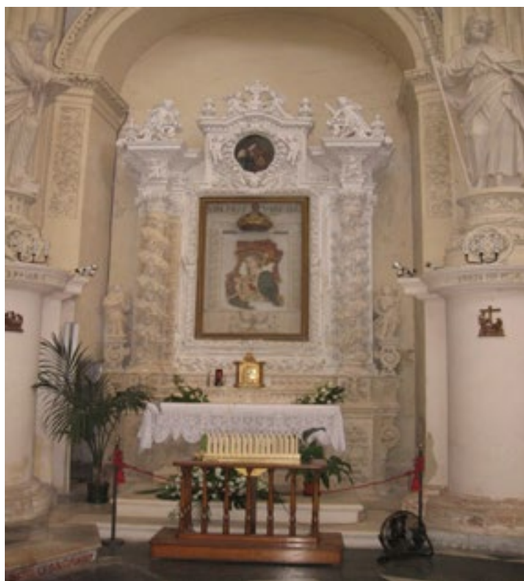
Fig.4 - Cappella laterale, umidità visibile lateralmente alla base della muratura.
