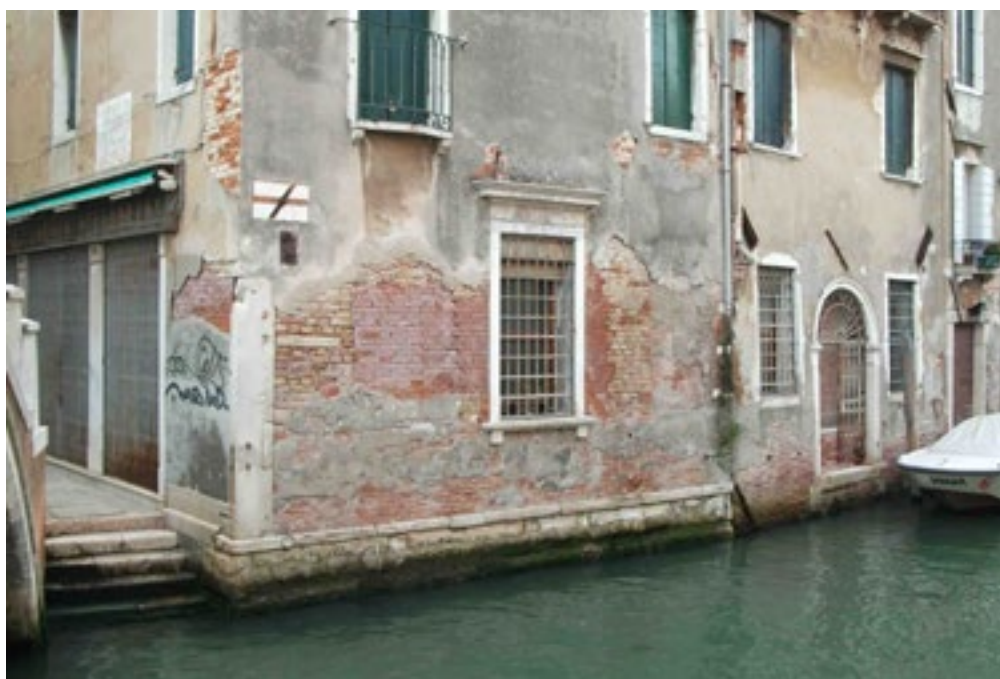
Fig.1 - Umidità da risalita sul prospetto esterno di un'abitazione a Venezia.
