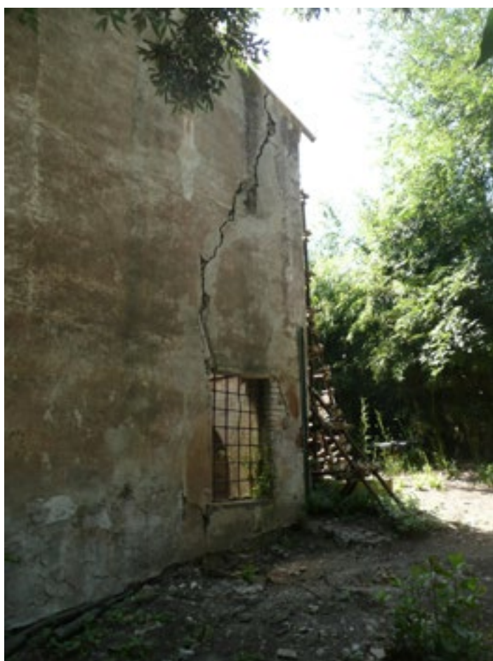
Fig. 4 - La parte soggetta a cedimento.
