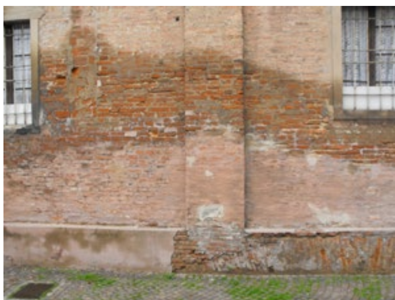
Fig.2 - Esiti postumi (ricomparsa dell'umidità) su una muratura precedentemente trattata con barriera chimica.
