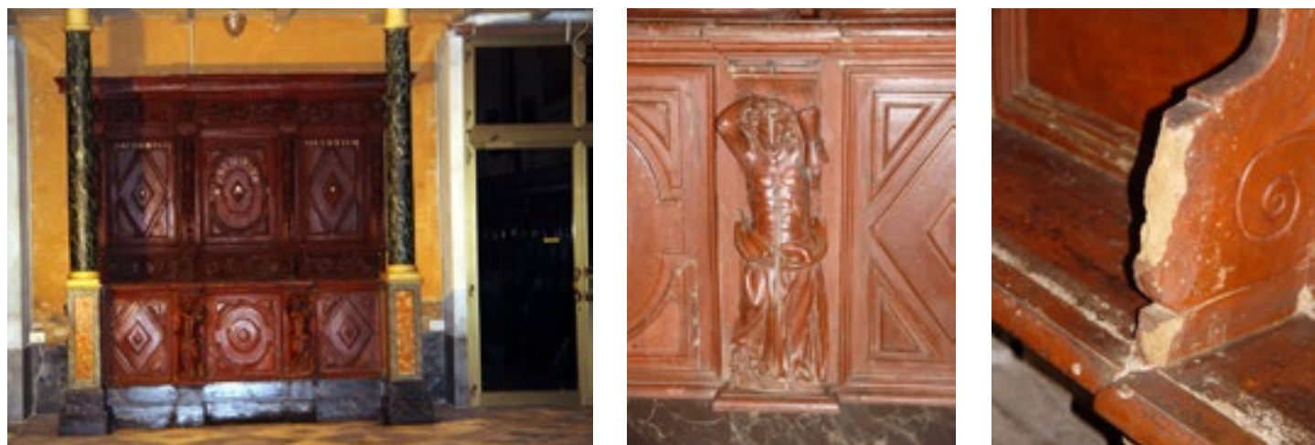
Fig. 25 – Gli stalli lignei cinquecenteschi, vista d'insieme e particolari dello stato di degrado
