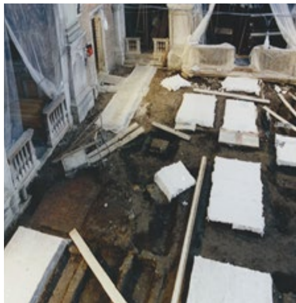
Fig. 6 - Chiesa di Sant'Antonin - veduta dall'alto degli scavi della pavimentazione, spesso invasa dall'acqua di marea.
