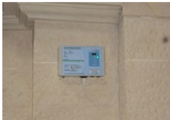
Fig.7 - Installazione dell'apparecchio a neutralizzazione di carica Domodry.
