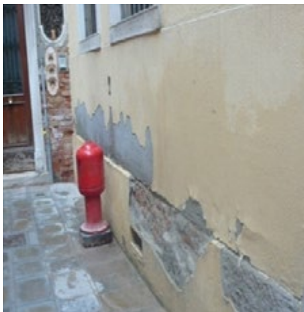
Fig. 8 - Intonaci deumidificanti: la loro efficacia nel permettere la traspirazione del muro è limitata nel tempo.
