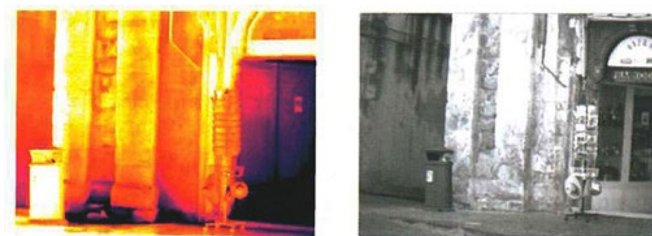
Fig. 15 - Noto (SR), Chiesa di San Lorenzo. Dall'immagine termica e nel visibile è possibile evidenziare il gradiente termico dalla parte bassa della muratura.
