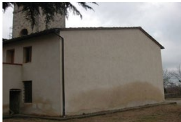
Fig. 8 - Immagine al visibile con evidente degrado sulla porzione bassa della muratura.
