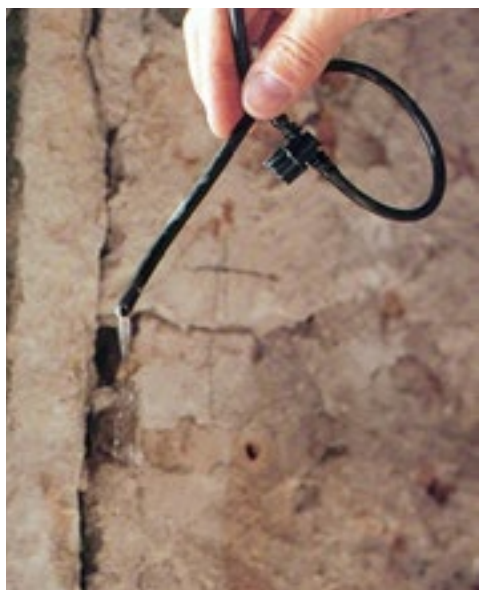
Fig. 9 - Desalinizzazione dei muri – particolare dei tubi utilizzati.
