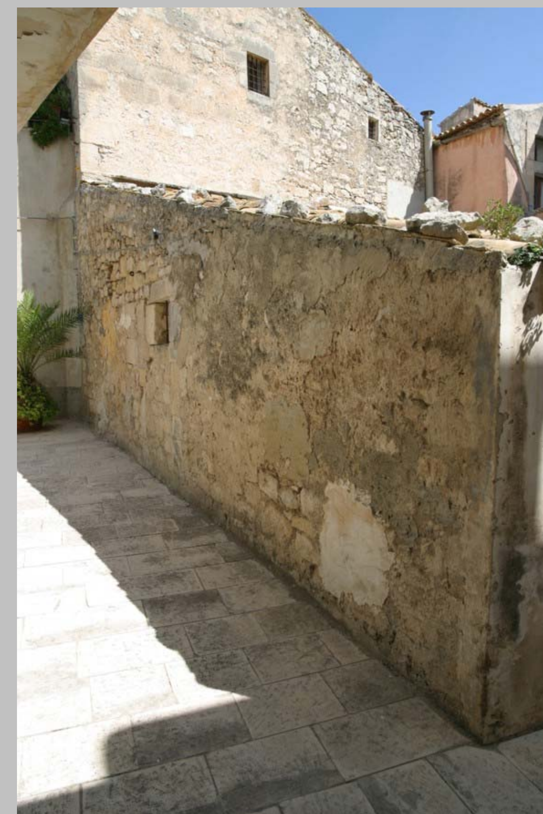
Unità edilizia n. 45 isolato n.76 soggetta a demolizione senza ricostruzione
