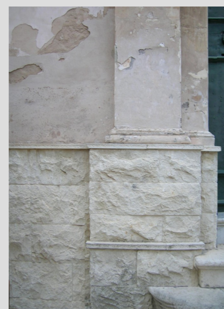
PALAZZO T3: SOVRAPPOSIZIONE BUGNATO DI CALCARE SU CONCI DI CALCARE LISCI, SOLUZIONE INADEGUATA NELLO SCHEMA COMPOSITIVO E NELLE CARATTERISTICHE MATERICHE
