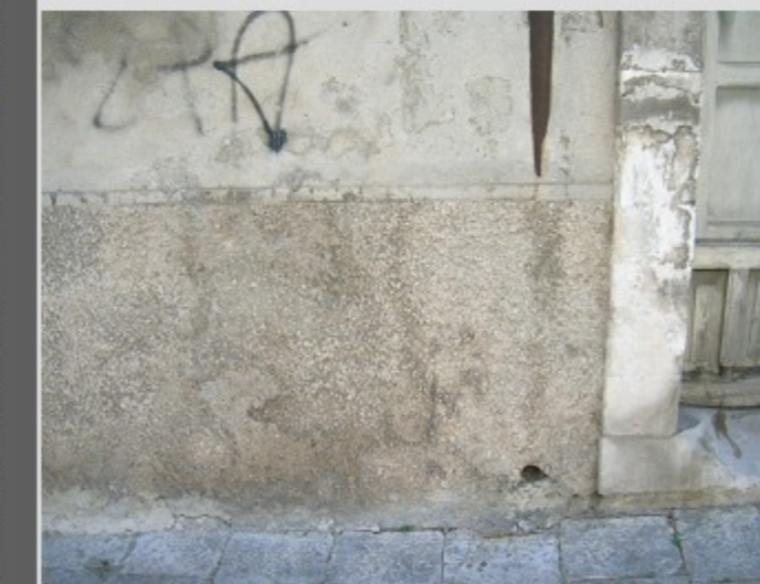
EDILIZIA DI BASE TI: APPLICAZIONE MALTA CEMENTIZIA RINZAFFATA
