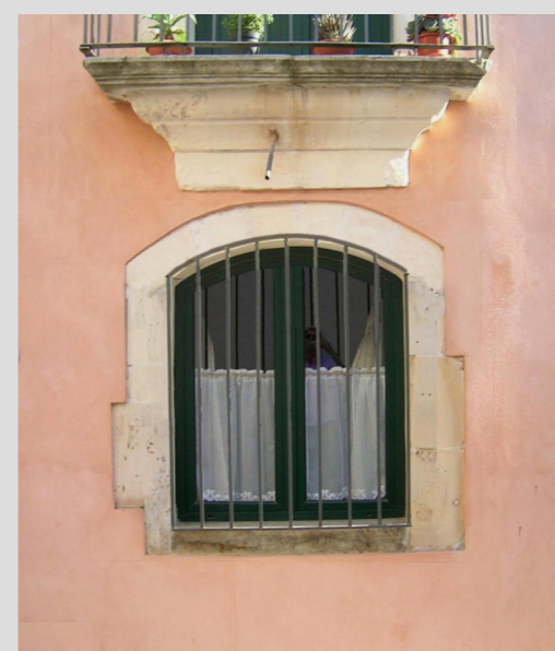
INFISSO E GRATA PROTETTIVA A DISEGNO SEMPLICE ,SOLUZIONE TIPICA DELL'EDILIZIA DI BASE DEL CENTRO STORICO
