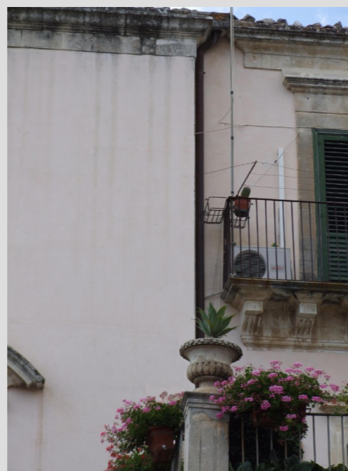
LIVELLAMENTO INTONACO IN PROSSIMITA' DELLA LINEA DI CONFINE CON ELIMINAZIONE DENTE DI SEGA
