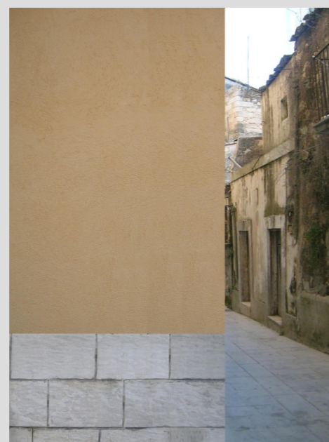
EDILIZIA DI BASE T1: APPLICAZIONE LASTRE IN PIETRA CALCAREA LISCIA A FORMA RETTANGOLARE CON LATO MAGGIORE POSTO IN ORIZZONTALE, A GIUNTO SFALSATO
